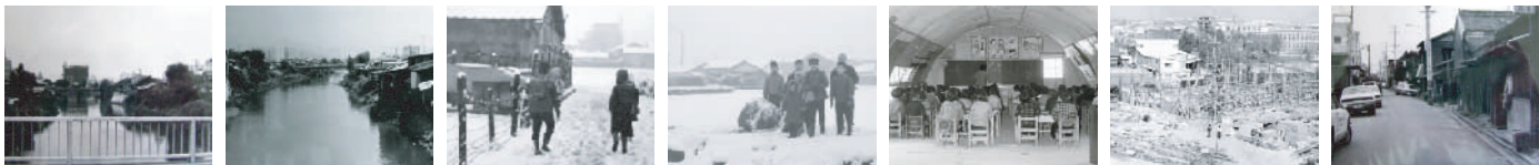
3 東光橋より堅粕橋(昭和40年頃) 4 東光橋より東比恵方向(昭和40年頃) 5 大雪の朝、建設中の新博多駅を望む(昭和38年冬) 6 大雪の朝、現空港通り(昭和38年冬) 7 かまぼこ兵舎教室(昭和32年) 8 旧体育館建設、福岡遠望(昭和38年) 9 比恵商店街遠望、現御笠川沿し(昭和55年)
